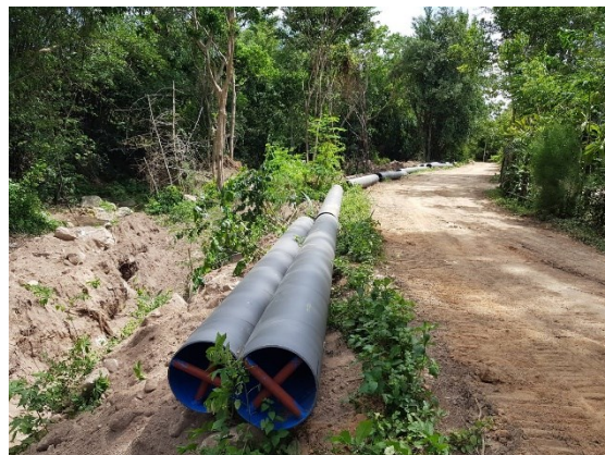
เตรียมวางระบบท่อส่งน้ำพร้อมอุปกรณ์ประกอบ
